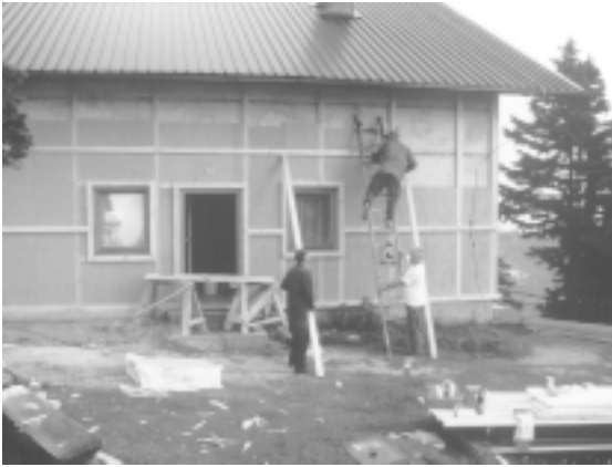
Izoliranje fasade s toplotno izolacijo Tervol, 17. 6. 2003
