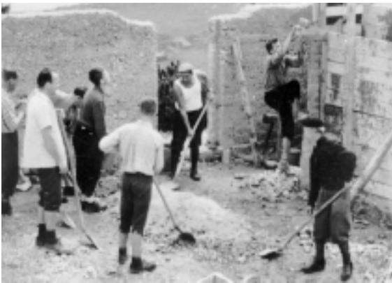
Betoniranje sten v kleti 1963
