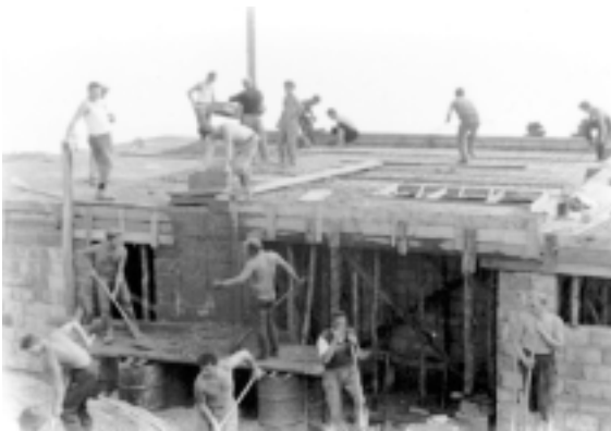
Betoniranje druge plošče 1966
